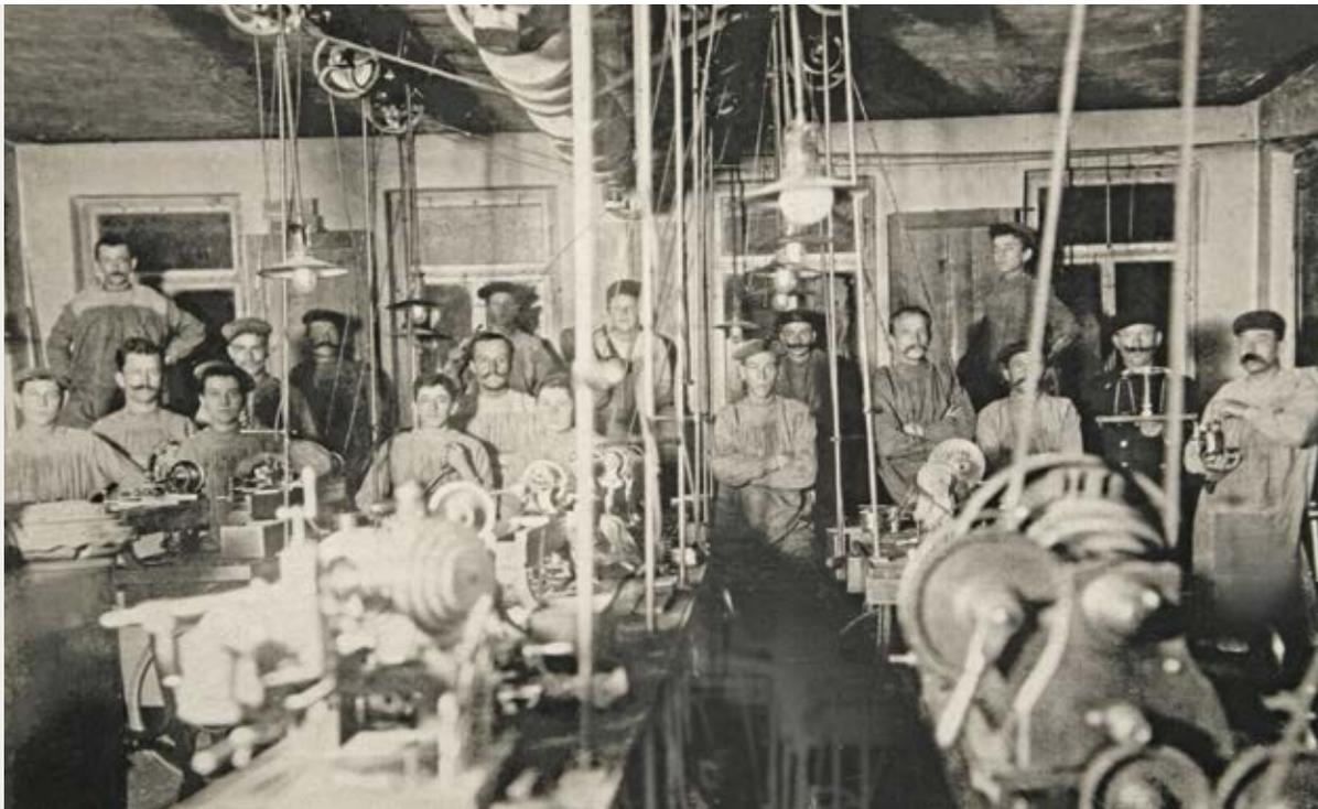
um 1900, ein Gasmotor treibt über eine Transmission an der Decke mittels Lederriemen die einzelnen Maschinen im Produktionsaal an
